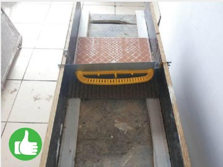
A mesa de aplicação de dupla colagem foi desenvolvida para facilitar a aplicação de argamassa colante no verso da placa. Esta mesa pode ser construída com madeiras existentes na obra.
